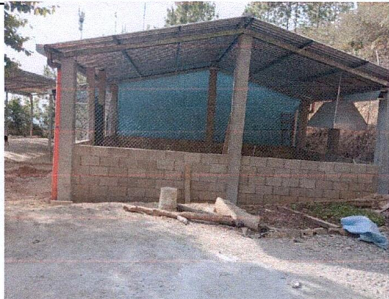
Foto 1: Mejoramiento con estructura tipo pórtico e instalación de lámina troquelada calibre 26 de la cocina finalizado
